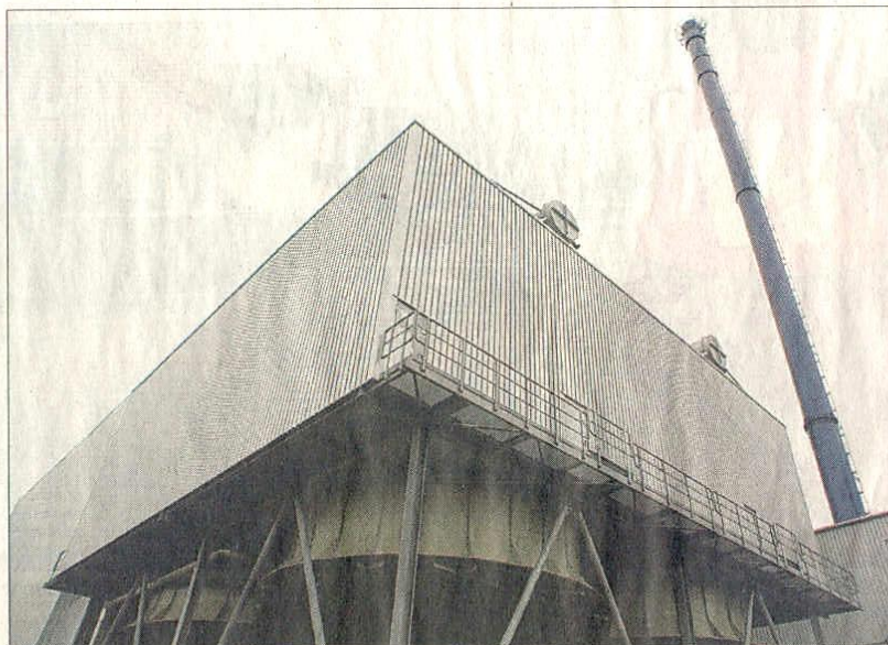
Das Prokon-Heizkraftwerk. Hier soll mit Teeröl verseuchtes Holz verbrannt werden. Der Betreiber hat versichert, es würden keine Schadstoffe dabei freigesetzt. BILD: EDEN
