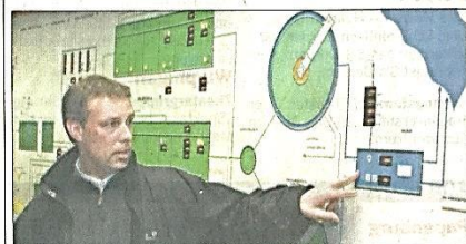
An der Schalttafel erläuterte Betriebsleiter Rolf Wessels die Einzelheiten der Anlage.
